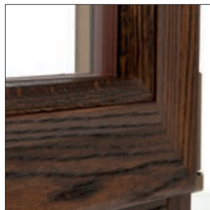
Tenone interno legno anta a 45° con profilo concav e fermavetro raccordato all'anta.
