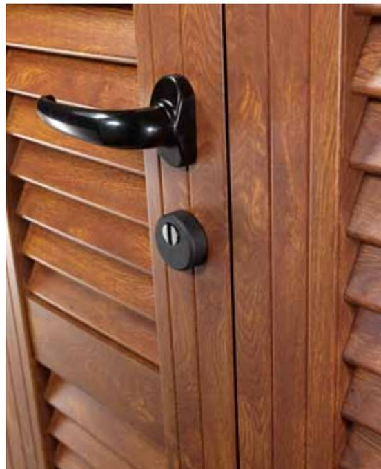
Dettaglio della maniglia e del defender esterno a protezione del cilindro antitrapano passante
